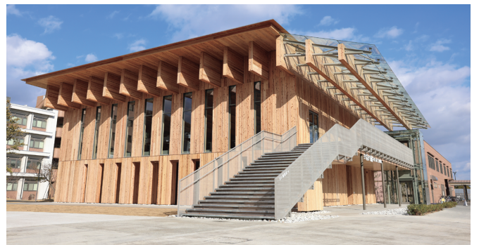
CLTを用いた木造建築の教材
